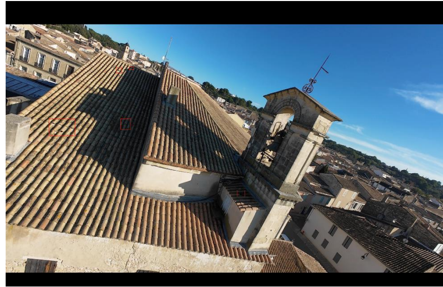
Toiture de l'annexe du Temple (côté rue Montcalm).
